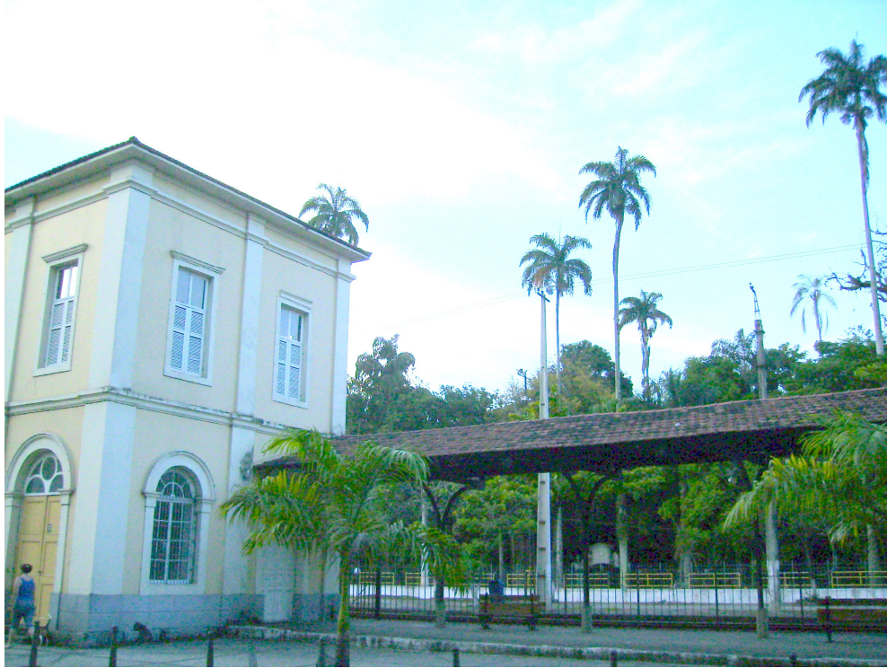
Figura 4 – Vista pela sacada do restaurante. Prédio da antiga estação férrea e as árvores do Parque Centenário.
