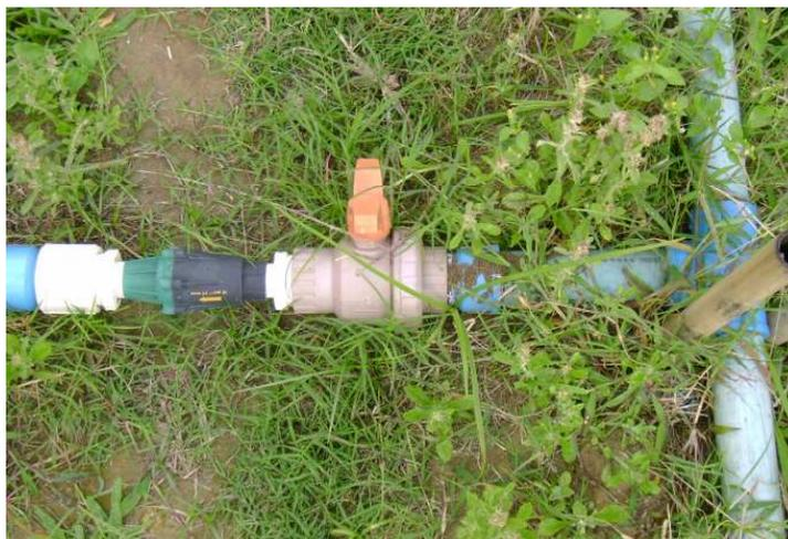
**Figura 3.** Cultivo orgânico da beterraba (*Beta vulgaris* 'Early Wonder Tall Top'): conjunto registro de esfera e válvula reguladora de pressão (210 kPa) para controle de vazão e pressão na linha de derivação (Seropédica – RJ, 2008).
