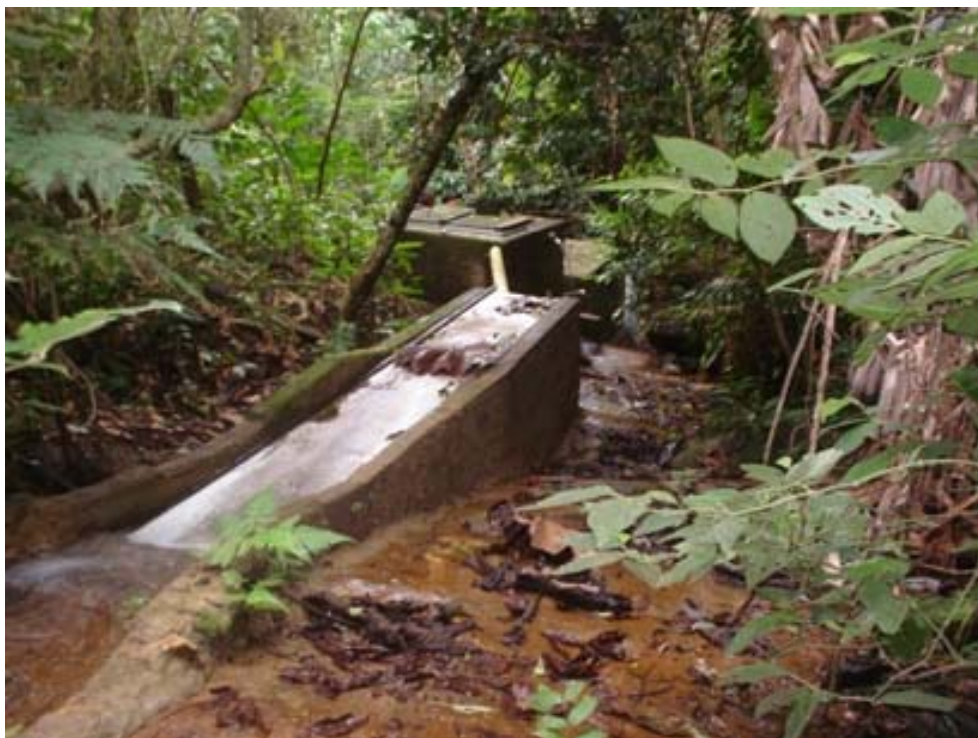
Figura 7. Estrutura da Captação da Glória
