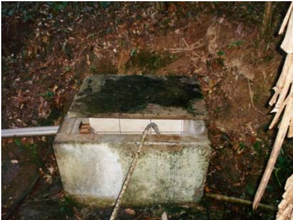
Figura 5. Estrutura da Captação do Palmital secundária.
