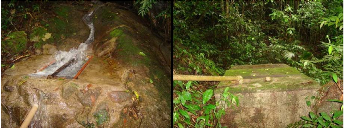
Figura 4. Estrutura da Captação do Palmital
