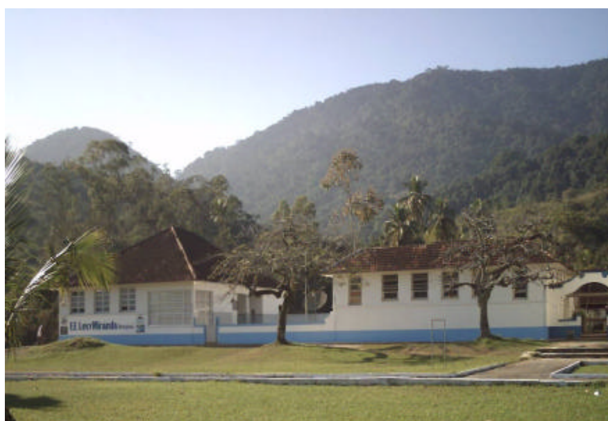
Figura 17 - Vista da fachada do prédio administrativo da Escola Municipal Levy Miranda. Fonte: trabalho de campo, 2008.
