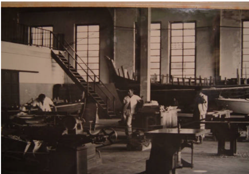
Figura 10 - Estaleiro: carpintaria naval e oficina mecânica.
