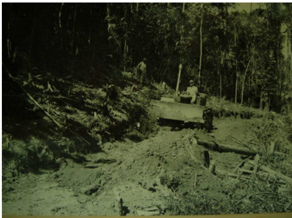
Figura 14 - Militar desmatando área para a abertura de estrada ligando as ex-instalações da Escola de Pesca (futura instalação da Marinha) à Praia da Armação (atualmente local de exercícios militares) - 1972. Também identificado por Silva, 2005.
