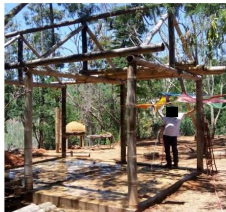
**Figura 15** - Ensaio para execução do contrapiso e compactação por molhagem, 2018.
