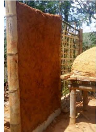
**Figura 13** - Parede de taipa (preparo do material, trama de madeira e ‘barreamento’), 2018.
