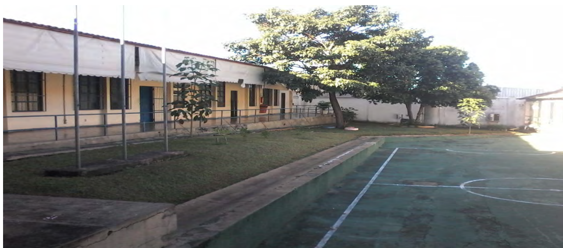
Foto 04 – Pátio descoberto e salas adaptadas para iniciarem as atividades acadêmicas. Fonte: arquivo do próprio autor.
