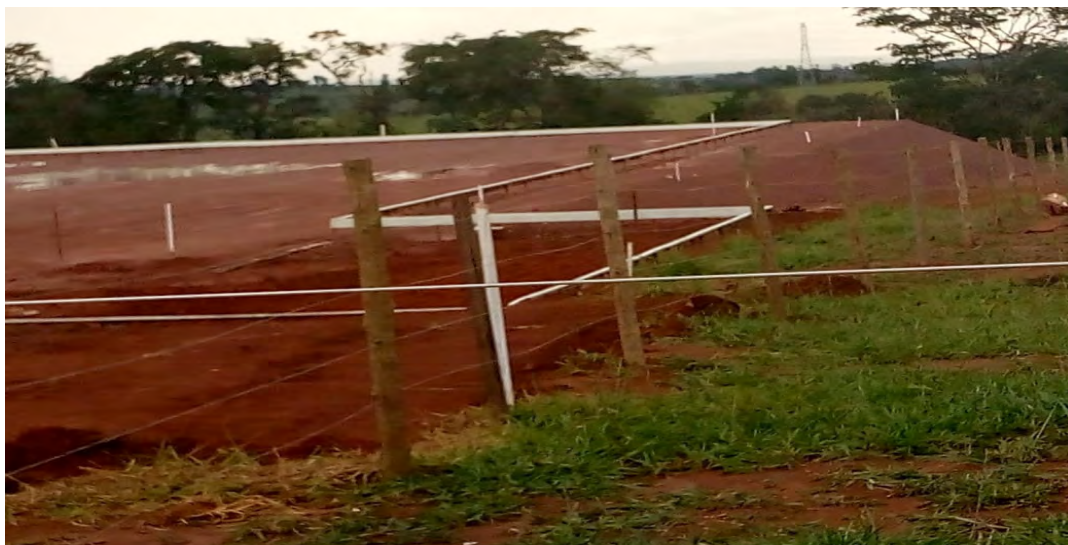
Foto 15 – Início das obras na área do prédio próprio do Campus Avançado Catalão. Fonte: arquivo de fotos do IF Goiano.
