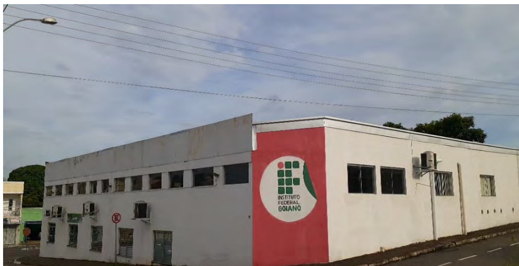
Foto 10 – Imagem dos fundos do prédio anexo que foi alugado pelo IF Goiano em 2015. Fonte: arquivo pessoal do próprio autor.
