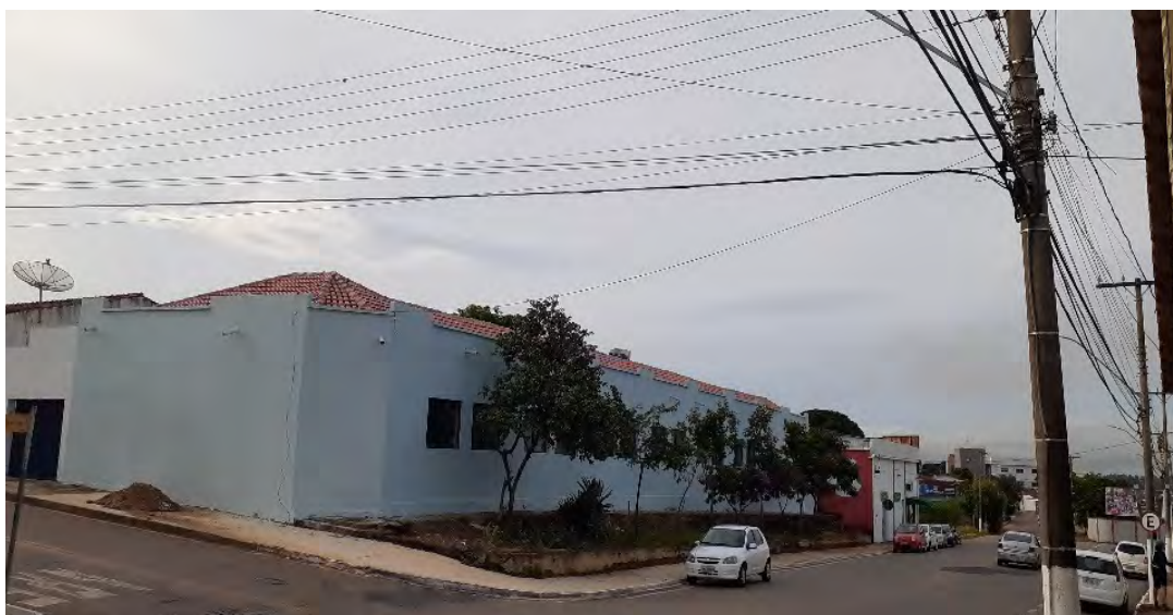
Foto 16 – Prédio devolvido pelo IF Goiano e depois reformado pelo Estado de Goiás. Fonte: Arquivo pessoal do autor.
