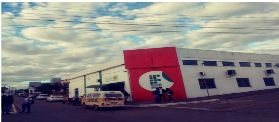
Foto 09 – Fachada do prédio anexo que foi alugado pelo IF Goiano em 2015.
