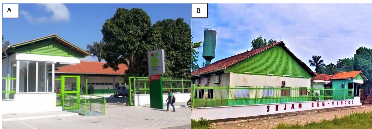
Figura 38 A e B. 38 A. Entrada do IFAM Campus Manacapuru, 2019; 38 B. Vista Lateral do IFAM Campus Manacapuru, 2020.
