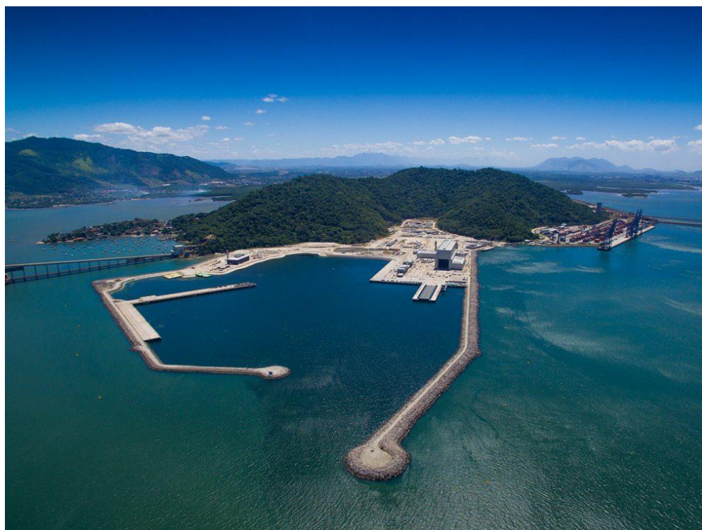
Figura 6 - Início das obras de estaleiro e base naval da Marinha do Brasil (2010) – Itaguaí/RJ
