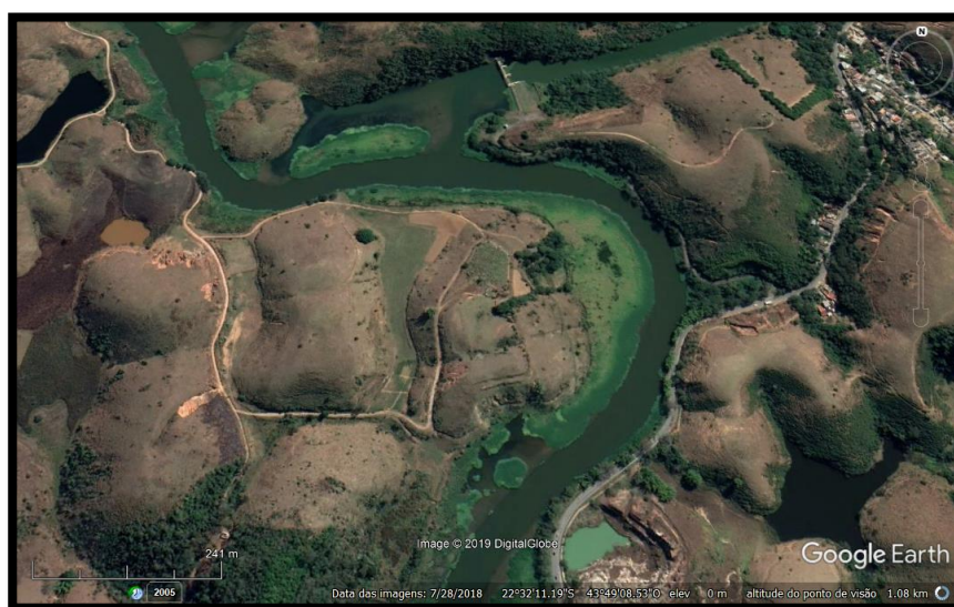
Figura 4. Vista parcial do reservatório de Santana.
