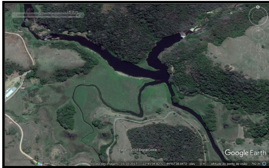
Figura 8. Vista parcial do reservatório de Tócos.
