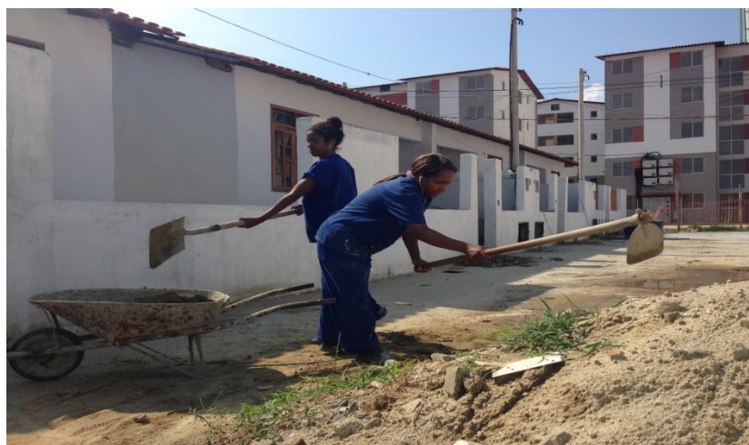
Foto do mutirão na construção das moradias
