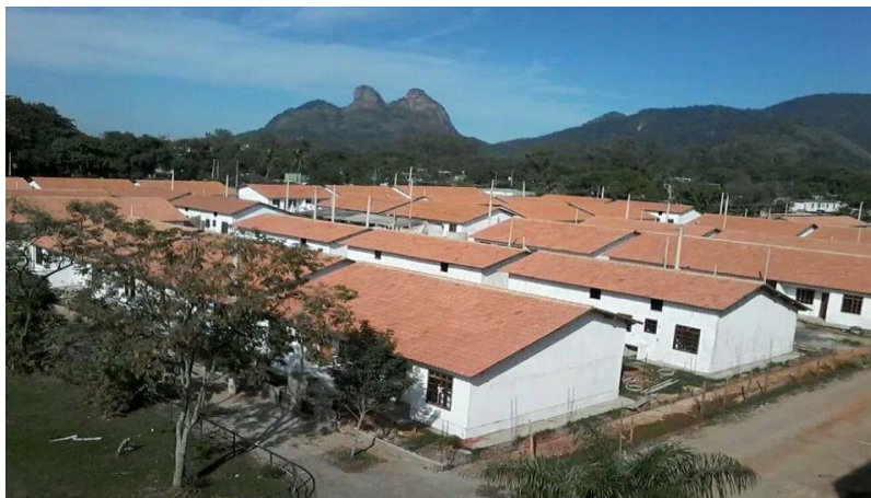
Unidades habitacionais da cooperativa esperança em fase de construção
