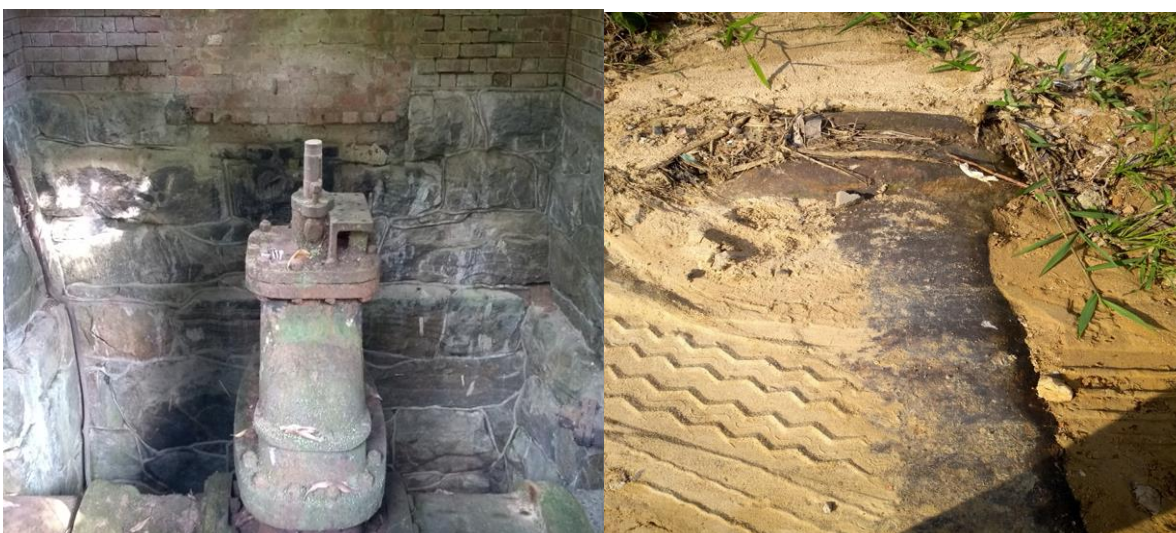
Duto situado na Via estrada de Ferro. Ligação Tinguá - Acari. Acervo pessoal – foto de 19/01/2021.
