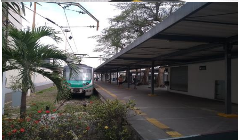
Estação de Belford Roxo em 2020.
