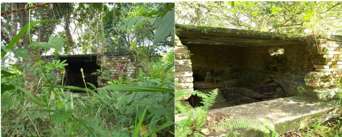
Hidrante da estação São Bernardino situado na Estrada de Ferro – Vila Iguazu Acervo pessoal – foto de 19/01/2021.
