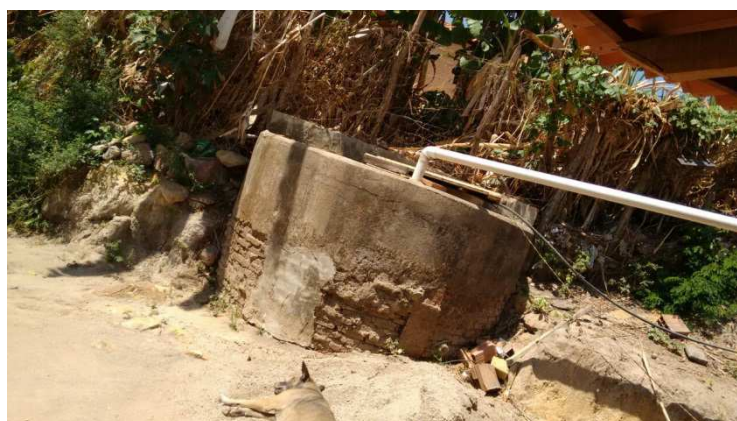
Figura 10: Cisterna construída pelos moradores da comunidade
