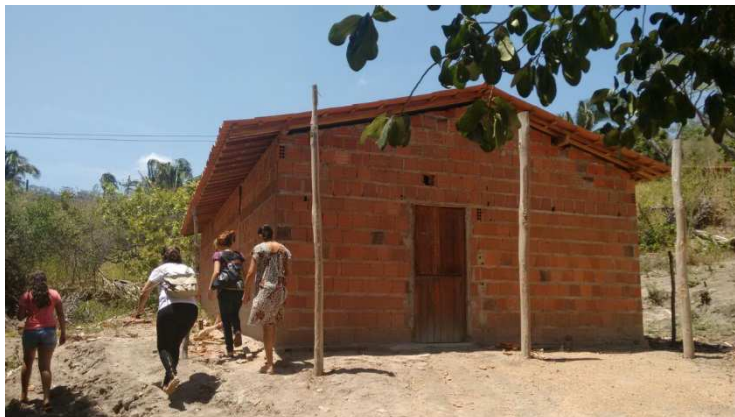
Figura 07: Casa de tijolos em construção no Sítio Palmeirinha
