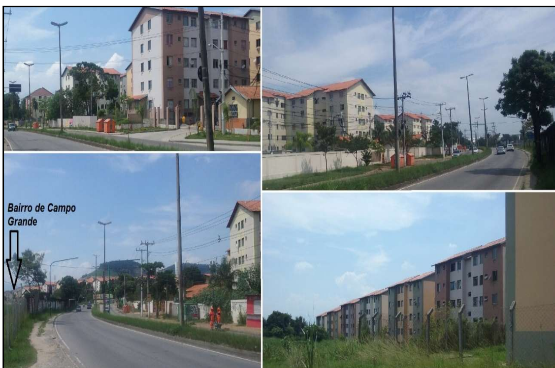
Figura 18: Condomínios do PMCMV I em Paciência - Estrada do Campinho
