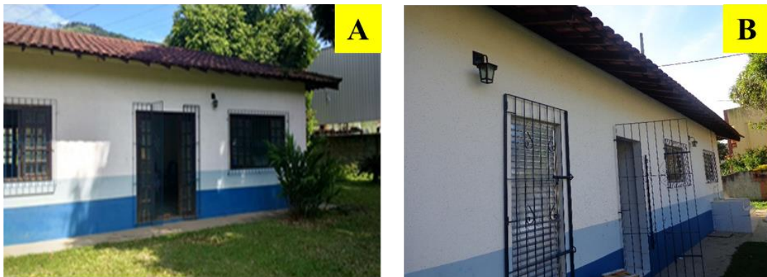
Figura 15. Entrada da sede da Agroindústria (A) e parte externa da Agroindústria (B).
