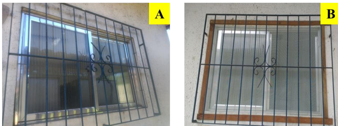
Figura 30. Janela sem proteção contra vetores (A) e janela com proteção contra vetores (B).
