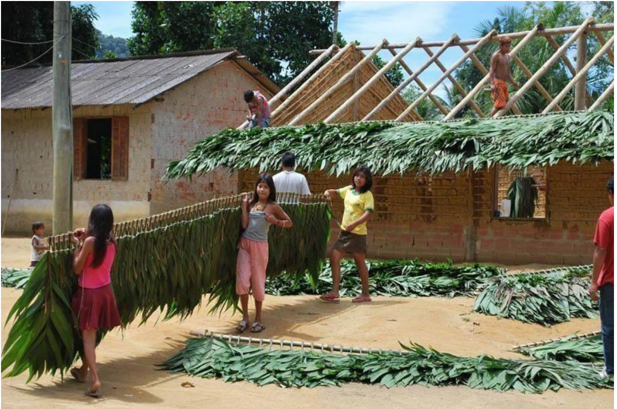
Figura 2: Jovens na ajuda da construção do telhado Tekoa – Sapukaí – RJ (Autor: desconhecido) (Fonte: Prefeitura de Angra dos Reis, 2014 apud BENITES, 2015, p.19).
