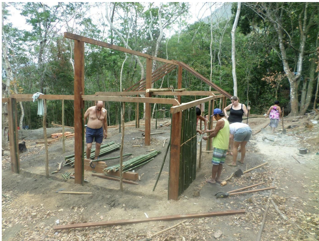
Figura 12: Grupo sendo orientado por seu Felix Karaí Mirim, durante o momento de corte e amarração do bambu para estruturação da parede, que depois veio a ser barreada. Aldeia de Itaipuaçu – RJ, Outubro de 2014 (foto: Emerson Guerra).
