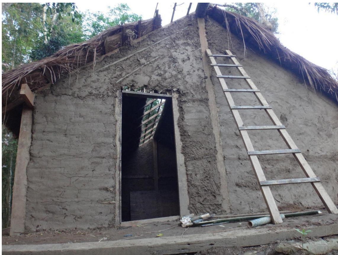
Figura 19: Opy casa de reza sendo finalizada sua construção. Setembro de 2016. (Foto: Emerson Gonçalves).
