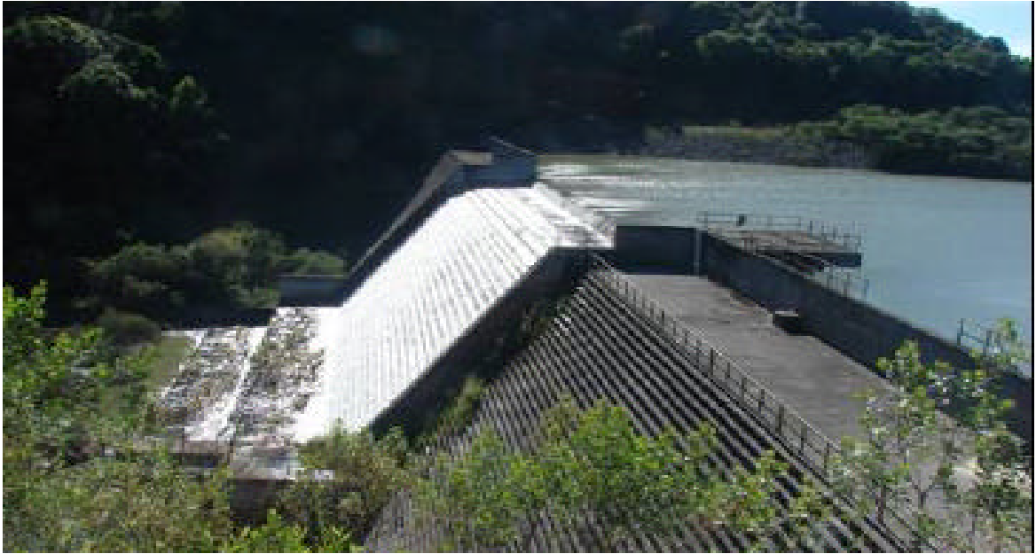
Figura 06 - Barragem São Miguel - captação do Arroio Burati - Atualmente o principal manancial de água bruta do município de Bento Gonçalves, com um volume acumulado de 2,8 bilhões de litros.
