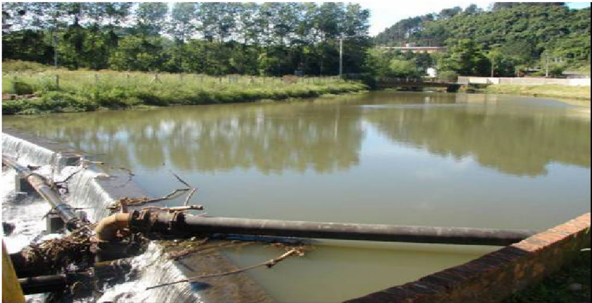
Figura 07 – Barragem do Arroio Barracão – cerca de 30% de água bruta é misturada com a do Arroio Burati para o abastecimento do município. Detalhe nas fotos para as linhas adutoras de água bruta, sendo a posicionada na frente do barramento, advinda da barragem do Moinho.
