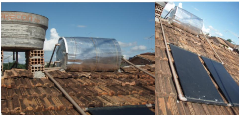
**Figura 8.2** – Aquecedor solar instalado numa das residências
