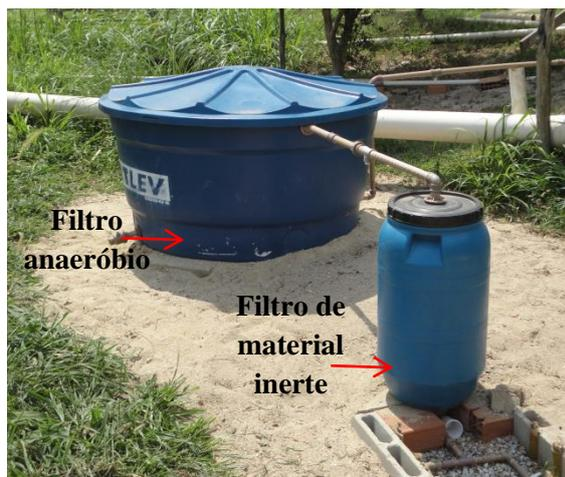
Figura 2. Filtro anaeróbico e filtro de material inerte.
