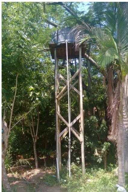
Figura 4: Reservatório de água responsável pelo abastecimento por gravidade do sistema de irrigação, instalado em área próxima ao experimento.
